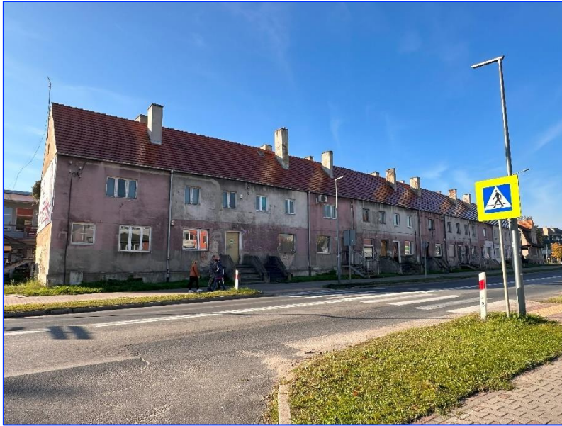
Ryc. 18 Budynek przy ul. Poznańskiej 8-30
