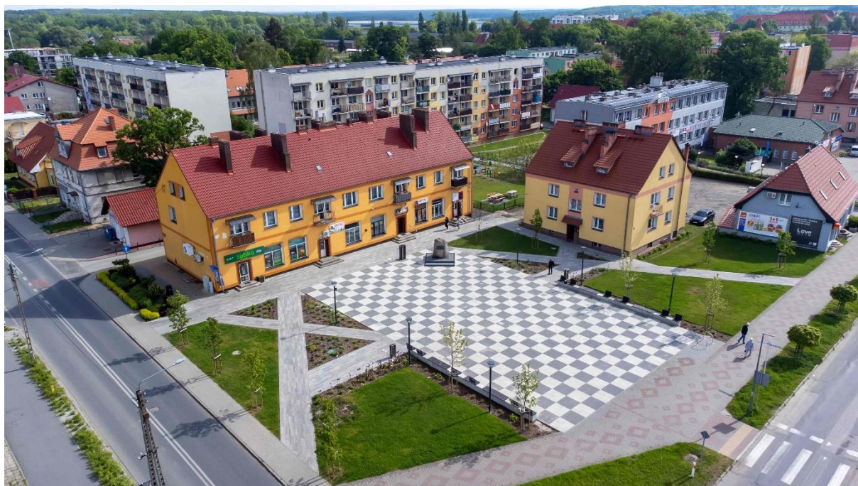
Fot. „Szachownica” po modernizacji, źródło: archiwum UM.
