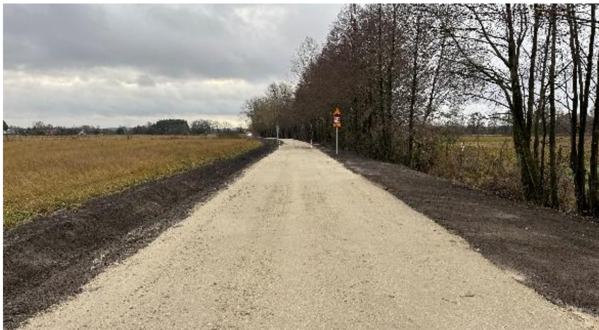
Fot. Droga gminna nr 000815F w Radnicy po przebudowie, źródło: archiwum UM.
