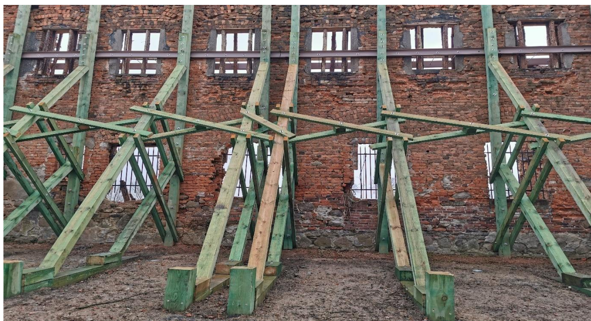
Fot. Zabezpieczone wschodnie skrzydło Zamku Piastowskiego, źródło: archiwum UM.
