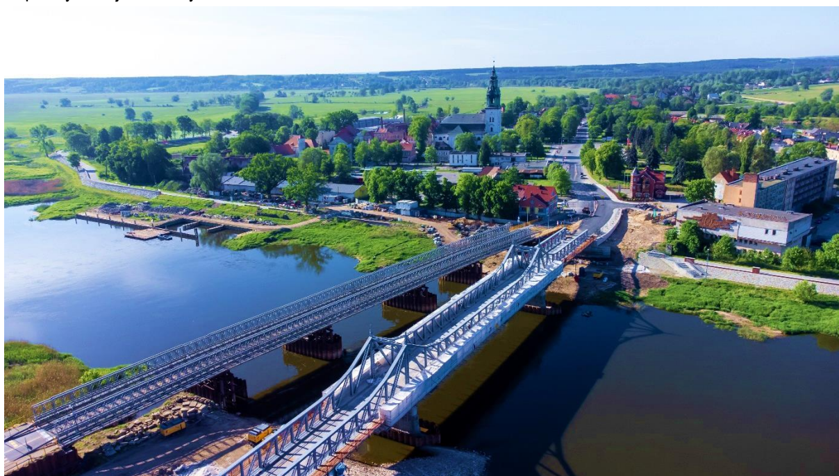
Fot. Widok na dwa mosty na Odrze i dolną część Krosna Odrzańskiego, źródło: archiwum UM.
