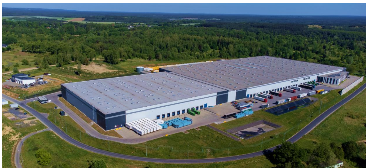
Fot. Centrum logistyczne firmy Dirks, źródło: archiwum UM.
