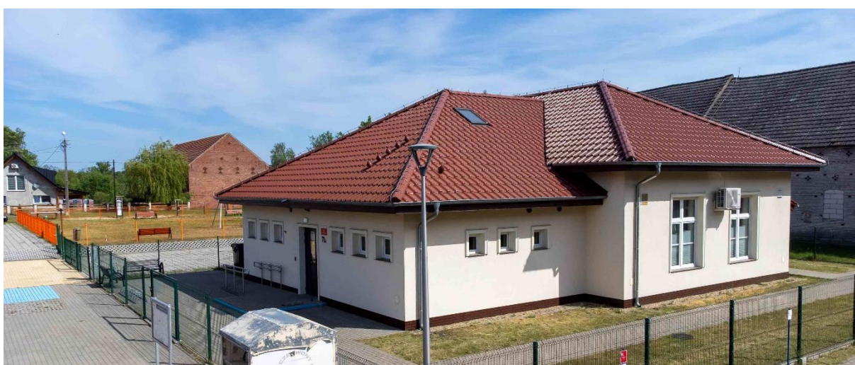
Fot. Świetlica wiejska w Starym Raduszczu, źródło: archiwum UM.
